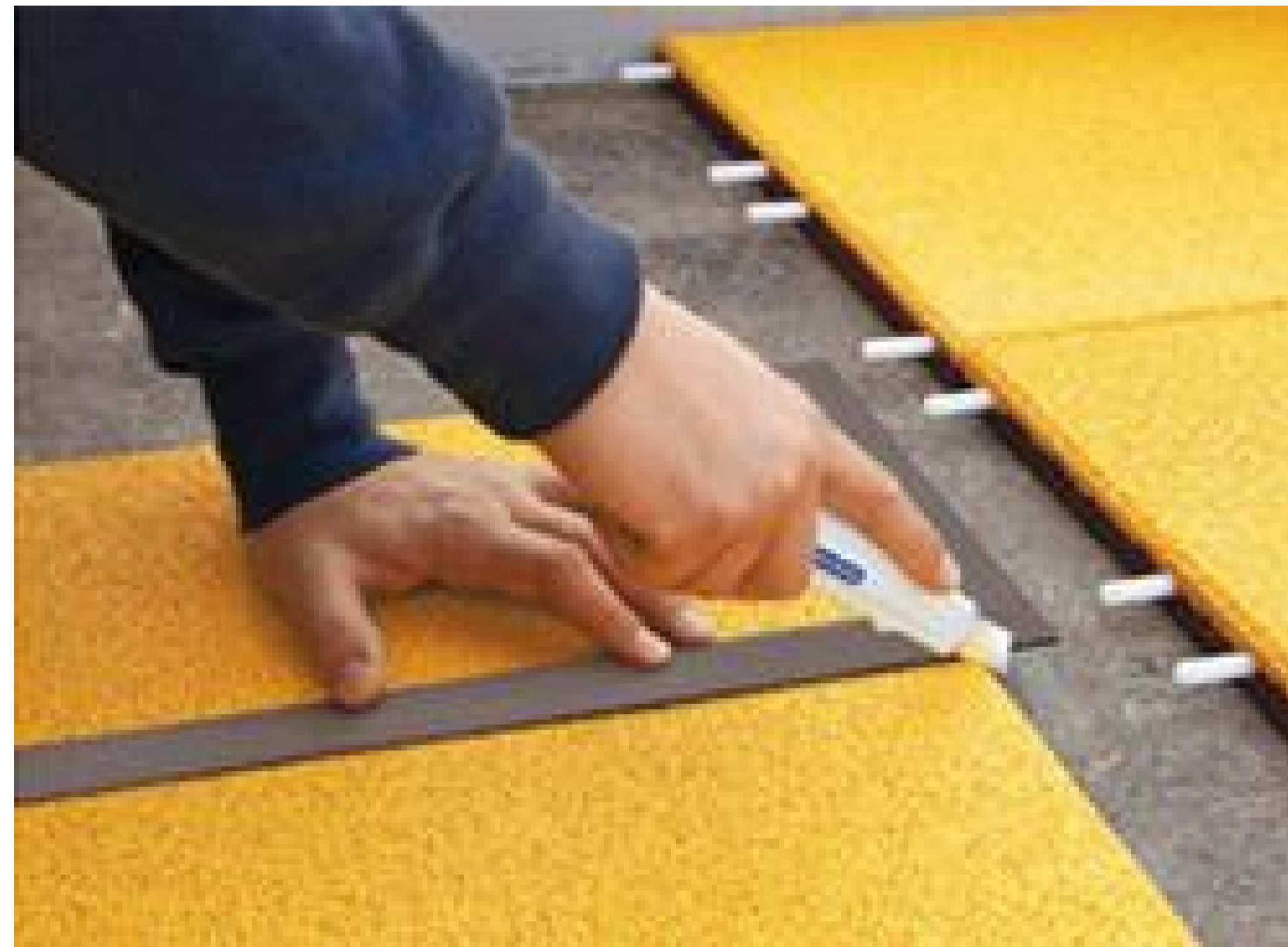
Рис. 6: Распиловка при помощи электролобзика на малом ходу или ножа для ковров
